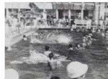
道路南側にあったプール
