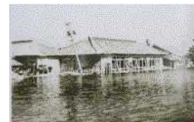
伊勢湾台風で被害が出た校舎
