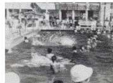
道路南側にあったプール
